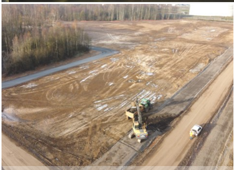
Site de la future ferme photovoltaïque sur le site pétrolier
